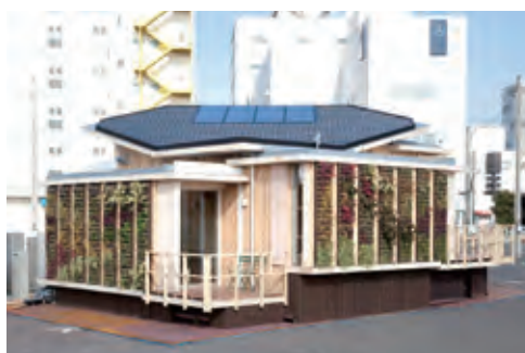
新しい木質構造材である CLT を使用
